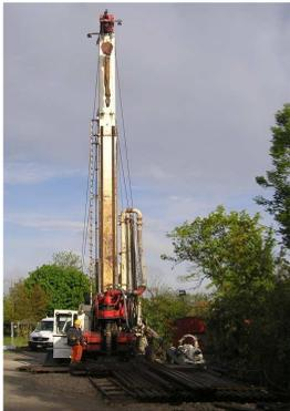
Realizzazione dei campi pozzi per alimentare sistemi a pompa di calore.
